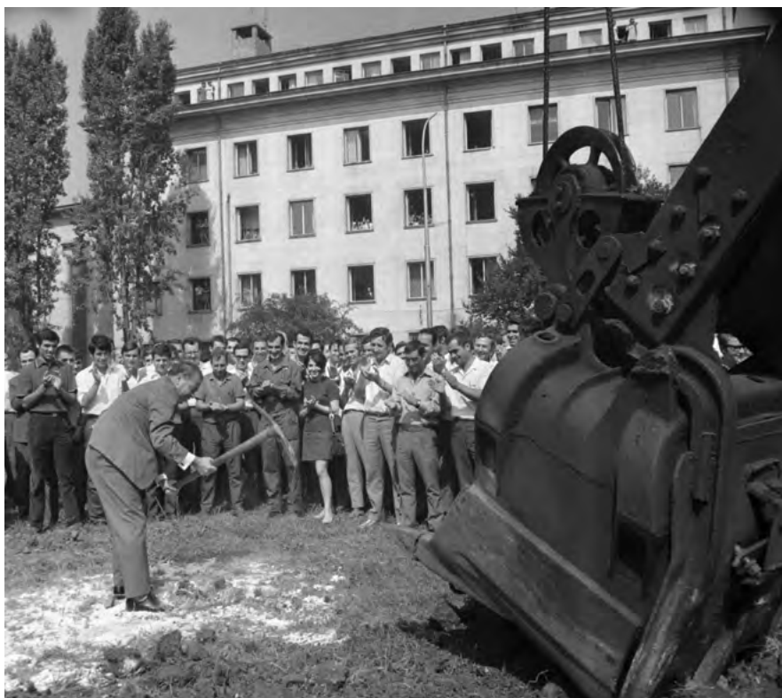
София, 16 септември 1970 г. Започва строителството на новата сграда на Българското радио. Първата колка е направена от председателя на Комитета за изкуство и култура Павел Матев. Снимка: Владимир Иванов, БТА
